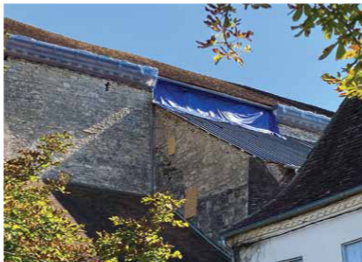
Protection de la toiture et sécurisation de la corniche
